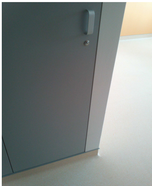
- vytažení PVC na sokl zabudovaného mobiliáře
